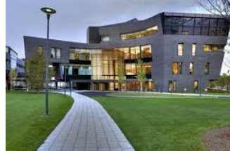
...schlecht schließende Fenster...
